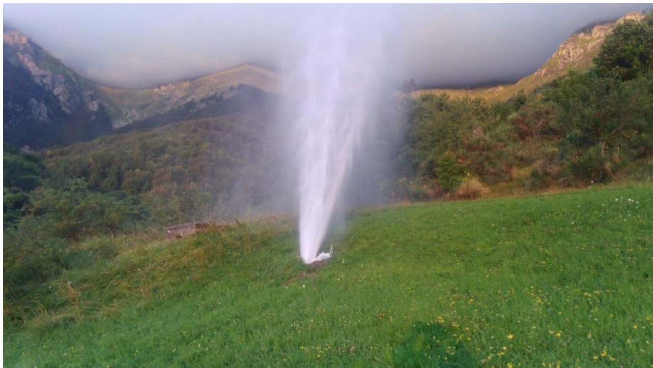
Prima rottura adduttrice DN250 Zona Colle Casale Comune di Montegallo
