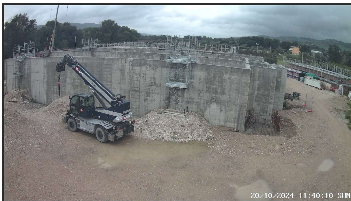
Vista da Sud: Realizzazione della vasca Biologica
