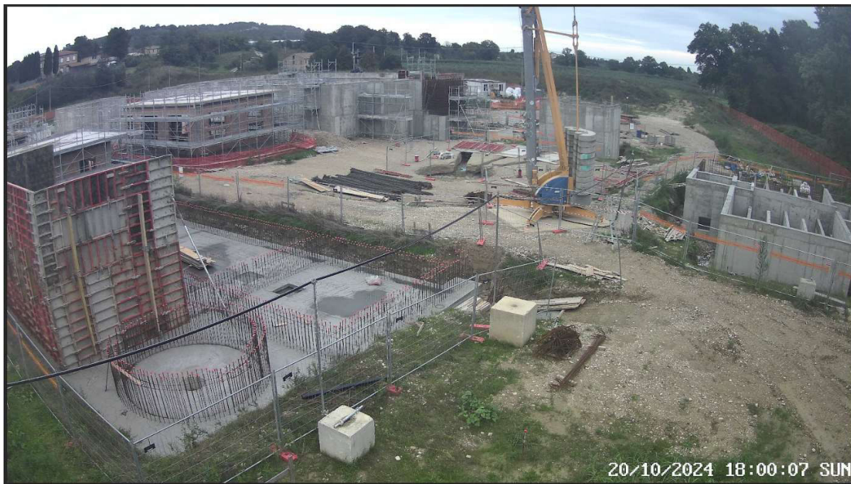
Vista da Sud-Ovest dell'area di cantiere: avanzato stato di realizzazione dei manufatti in c.a.
