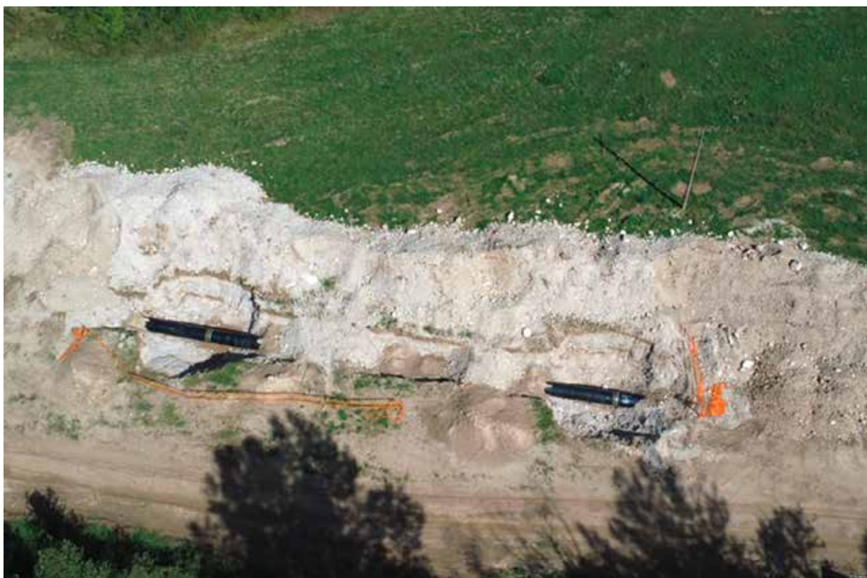
Tratto in fase di posa
