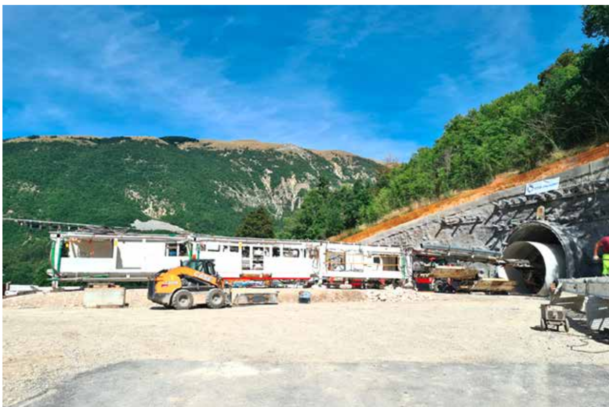
Montaggio TBM nel preforo della Galleria di Grisciano
