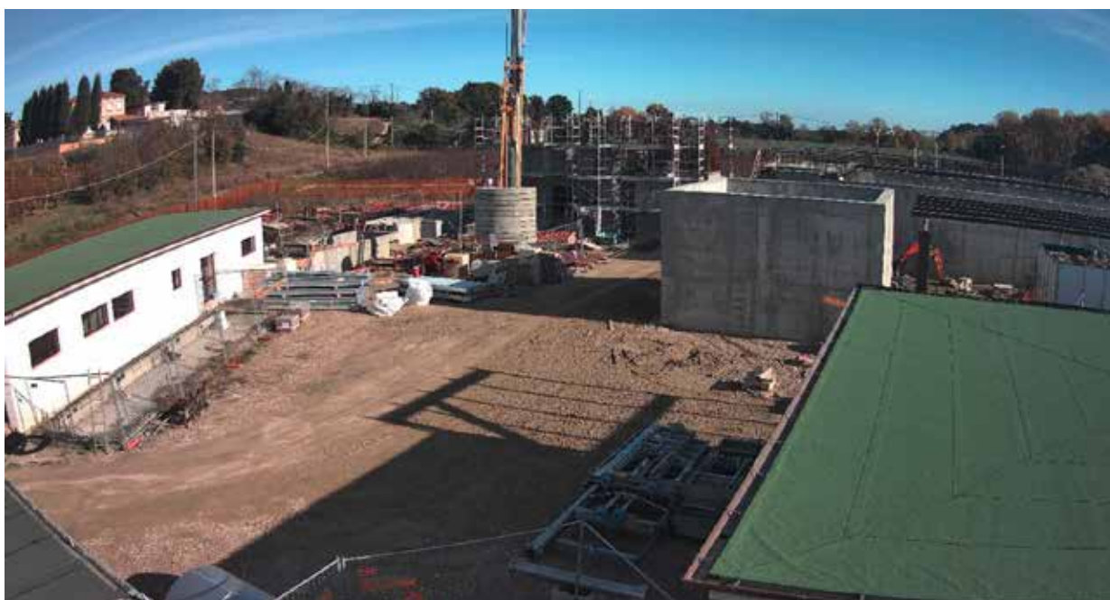
Vista da Ovest Depuratore di Altidona_Manufatto N06 (Locale Uffici) e N02 (Vasca di Equalizzazione) e N13 (locale Addensatore e Centrifuga Fanghi)
