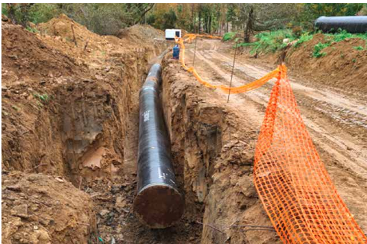
Fasi di posa delle condotte
