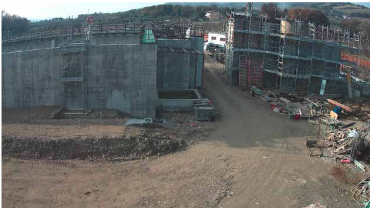
Vista da Est - Depuratore di Altidona_Manufatto N01 (Pretrattamenti) e N03 (Selettore Anossico e Vasca Biologica)
