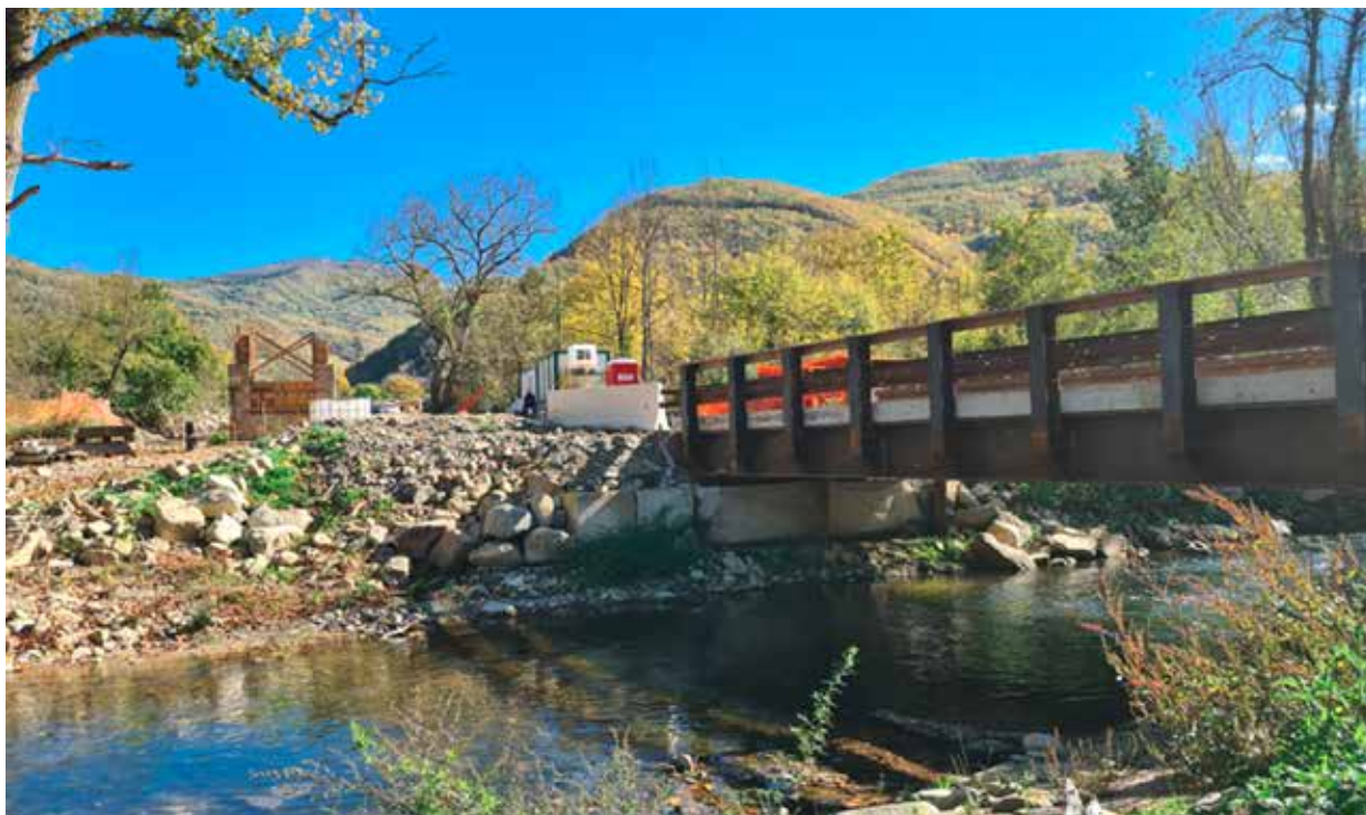
Ponte provvisorio e spalla ponte lato salaria
