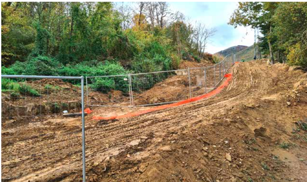
Fasi di posa delle condotte
