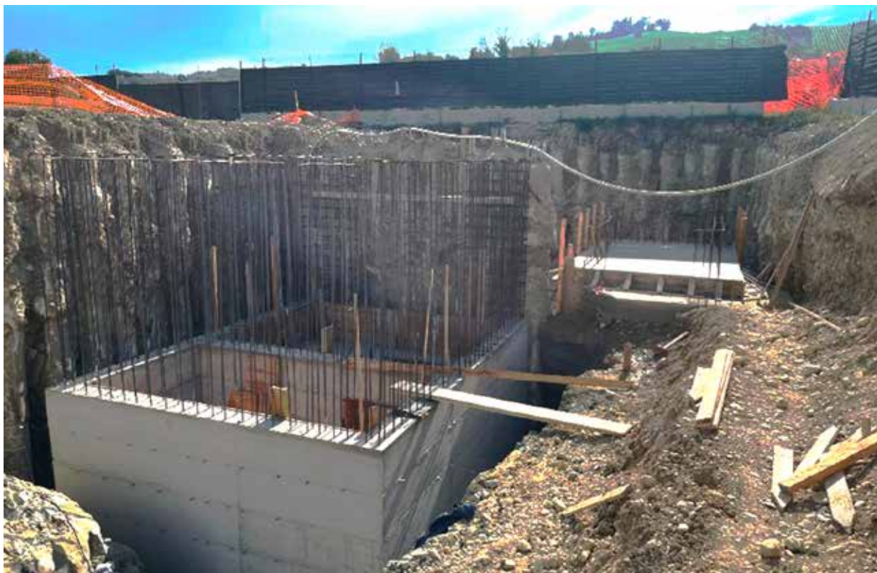
Lavori in corso presso l'impianto di Santa Maria Goretti
